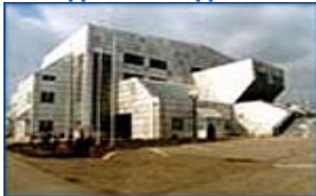
СПОРТСКА ХАЛА *ЈЕЗЕРО* - КЛАДОВО
